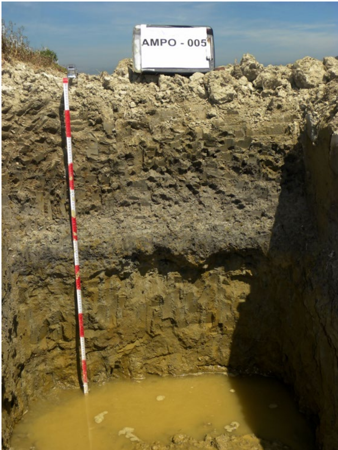
Secuencia de horizontes: Ap-Apdg-Bwkg/Bwk-Bkm-2C(sedimentos) Cartografía de suelos a escala 1:25.000 de la hoja de Amposta (ICGC, 2014).
